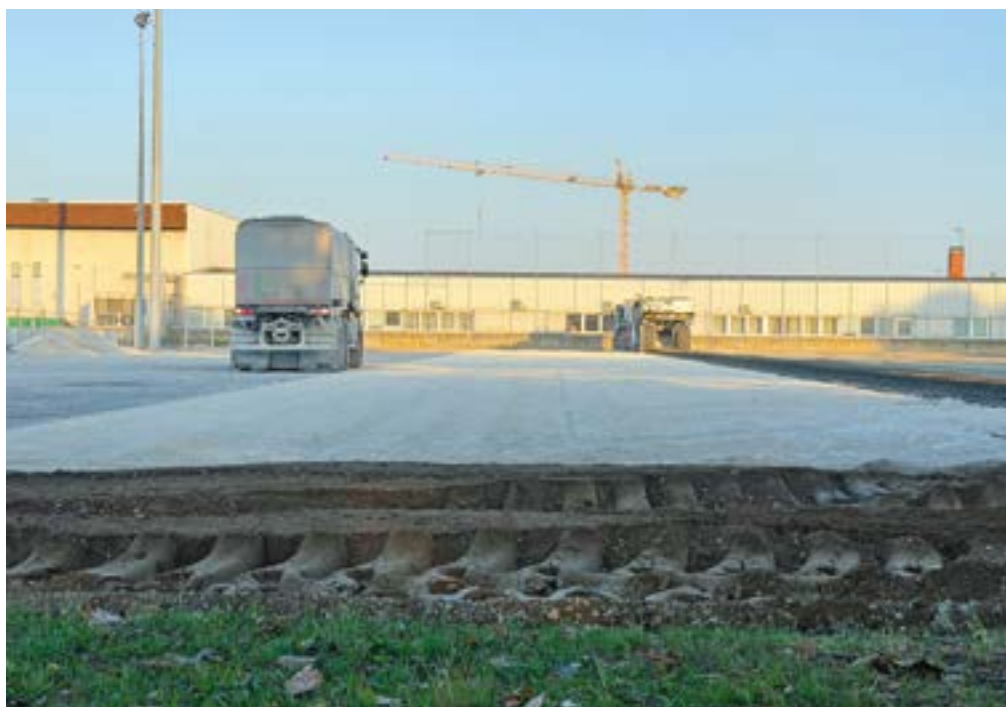
—Photo 2— Mise en œuvre de chaux en génie civil.
