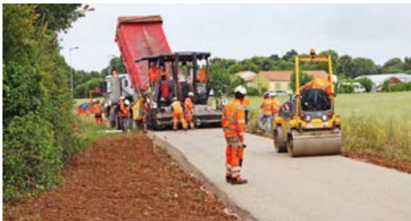
—Photo 4— Mise en œuvre du BC2R.
